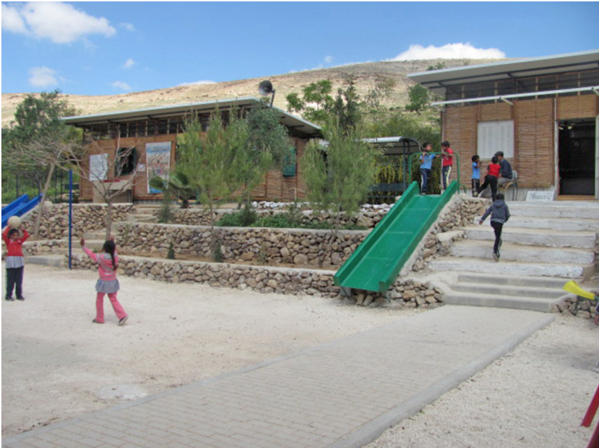
FIGURE 13.2 ARCò Architettura & Cooperazione, Wadi Abu Hindi school (2013).
