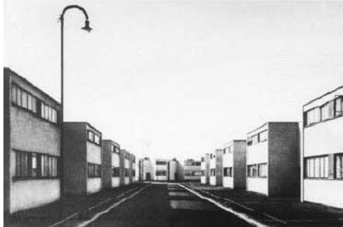
איור 3/ סטנדרטיזציה בייצור שכונות מגורים: שכונת טרטן (Törten) בדסאו, גרמניה (1930) בתכנון ולטר גרופיוס (מקור: ארכיון הבאוהאוס)
